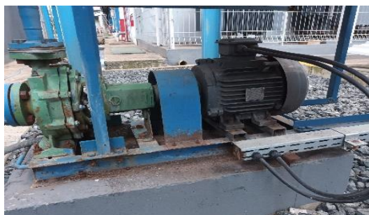
Gambar 11. Pompa Sirkulasi untuk Frame Penahan Castable
