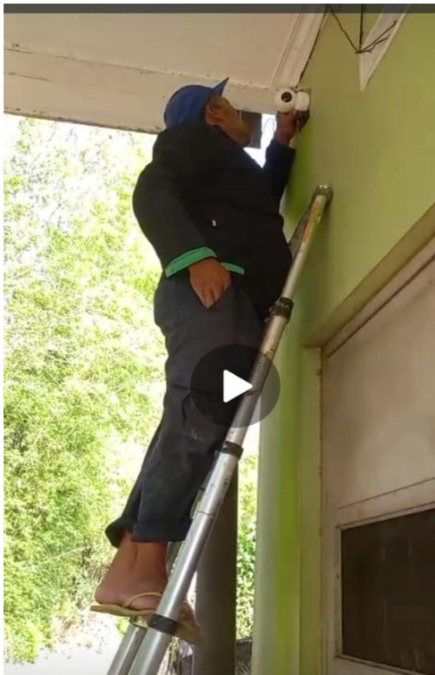
Gambar 2. Pemasangan Kamera Outdoor di Area Parkir Pondok Sirojul Qur'an di Jl. Joyopranoto Dalam No. 601 D.
