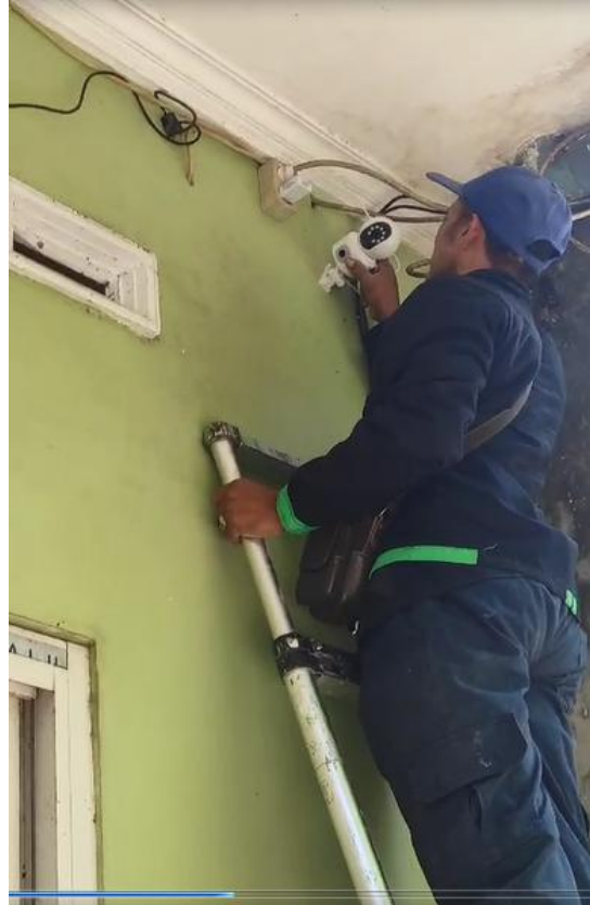
Gambar 4. Pemasangan Kamera Outdoor di Area Parkir Pondok Sirojul Qur'an di Jl. Tirto Rahayu Gang 11 RT 06 RW 05.
